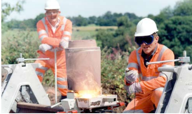
İşlem aynı, ray kaynağı çalışması. İki resim arasındaki benzerlikleri bulmaya çalışalım. Soldaki fotoğraf İngiltere'den. Sağdaki fotoğraf ise güzel ülkemizin bir köşesinden, bizden bir yol çalışması. Ray kaynağı yapılıyor. İpucu vermeye gerek var mı sizce?
