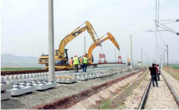
36 metre boyunda ray en az dört noktadan kavranarak indirilmeli ve taşınmalı raya kesinlikle sert bir cisimle vurulmamalıdır.
