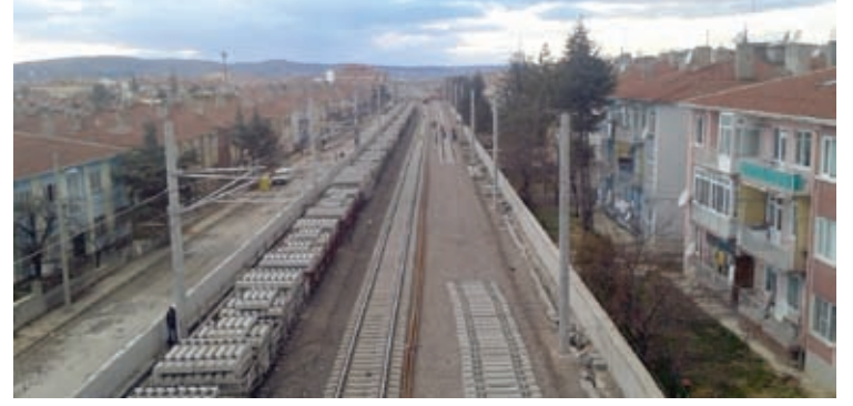
Eskişehir Gar geçişi üstyapı ve elektrifikasyon yapım işi kapsamındaki hat üst yapısı işleri
