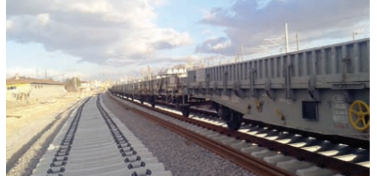
Eskişehir Gar geçişi üstyapı ve elektrifikasyon yapım işi kapsamındaki hat üst yapısı işleri
