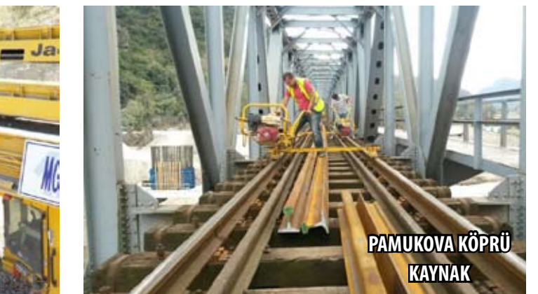
PAMUKOVA KÖPRÜ KAYNAK
